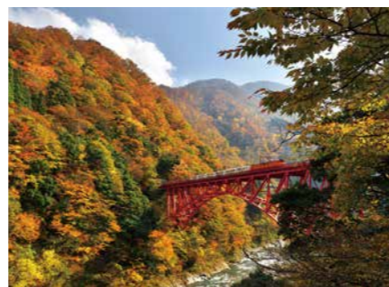
黒部峡谷トロッコ電車 (黒部市)
